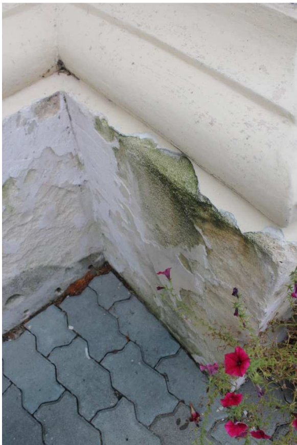
Fot. 9. Kościół w Radzyniu Podlaskim, uszkodzenia na strefie cokołowej kościoła.
