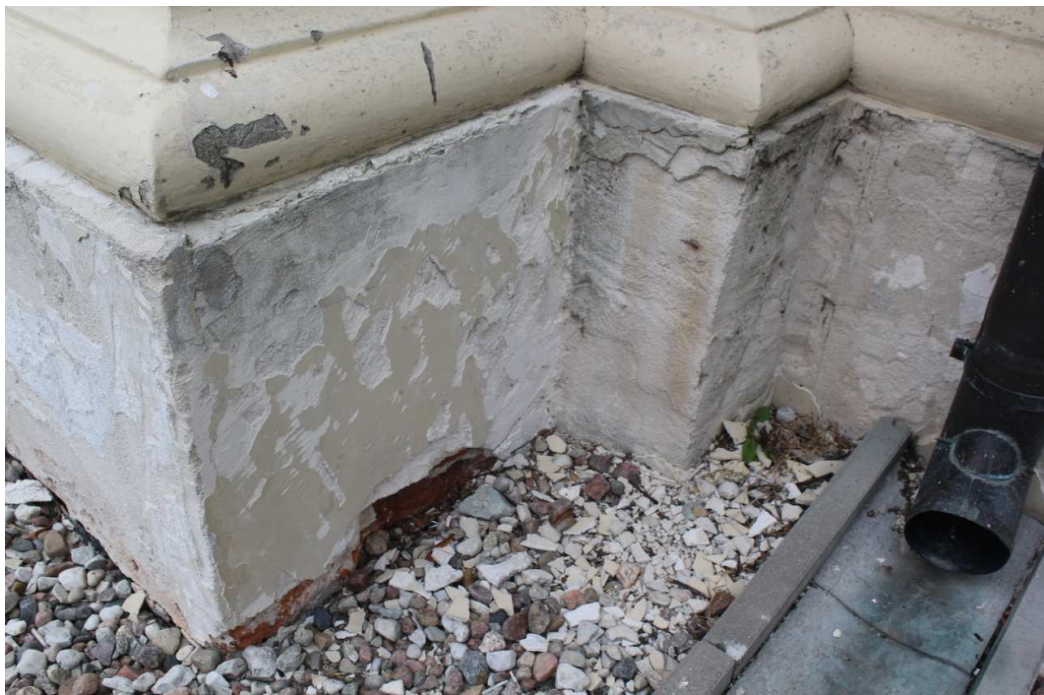
Fot. 3. Uszkodzenia wierzchniej warstwy tynków cokołowych, widoczne również czarne naloty zielenic.
