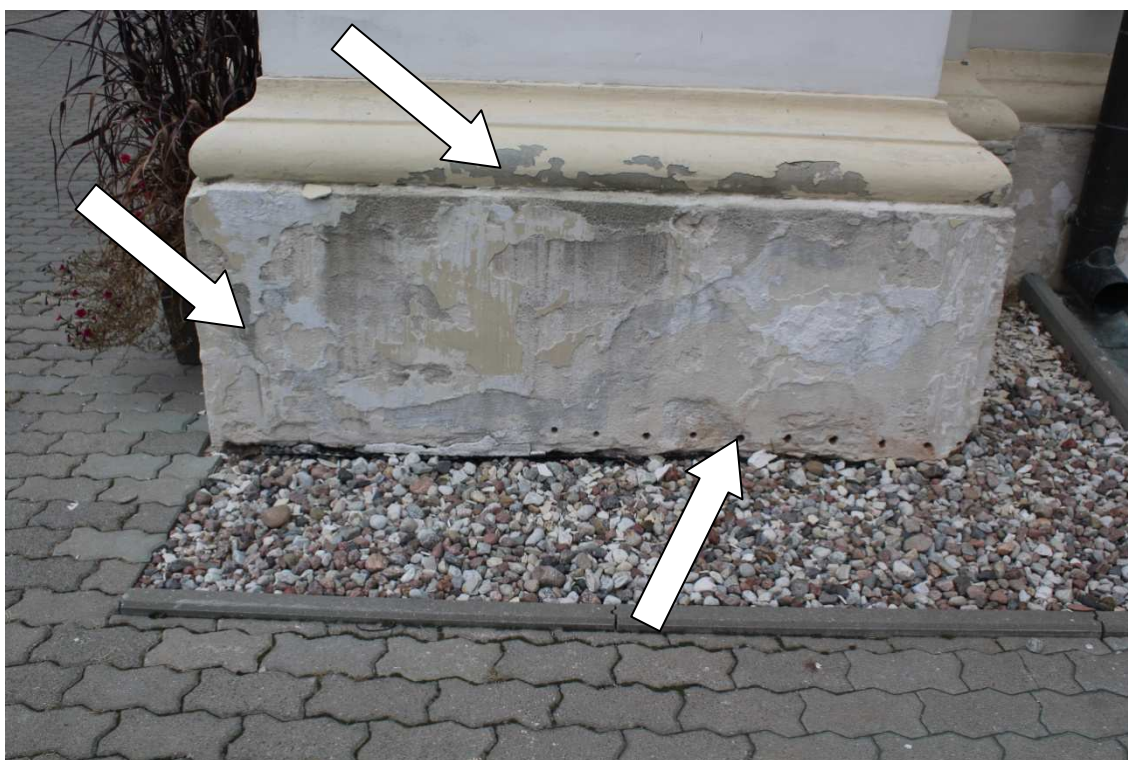
Fot. 1. Uszkodzenia wierzchniej warstwy tynków cokołowych, widoczne również złuszczenia farby na profilu cokołowym, widoczne otwory po iniekcjach.
