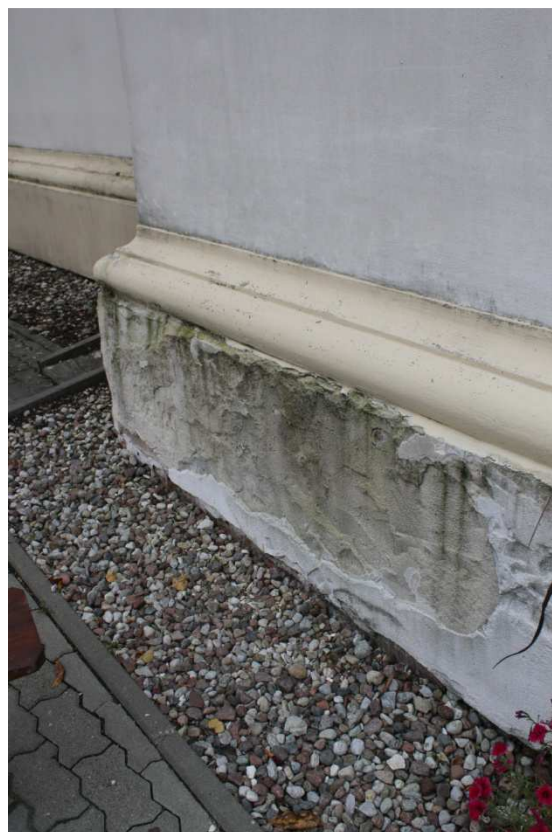
Fot. 8. Kościół w Radzynie Podlaskim, uszkodzenia na strefie cokołowej kościoła.
