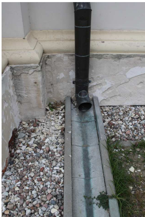
Fot. 7. Kościół w Radzynie Podlaskim, oprowadzenie wody z rur spustowych za pomocą korytek.
