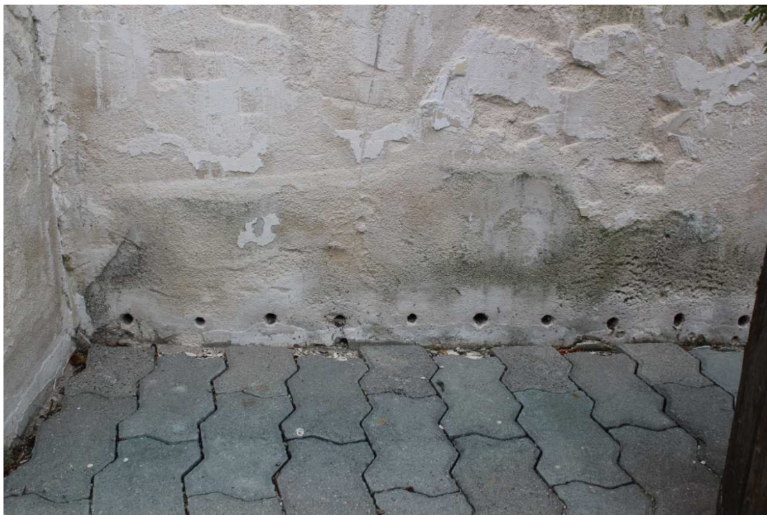
Fot. 11. Kościół w Radzyniu Podlaskim, uszkodzenia na strefie cokołowej kościoła, widoczne wcześniej wykonane iniekcje.
