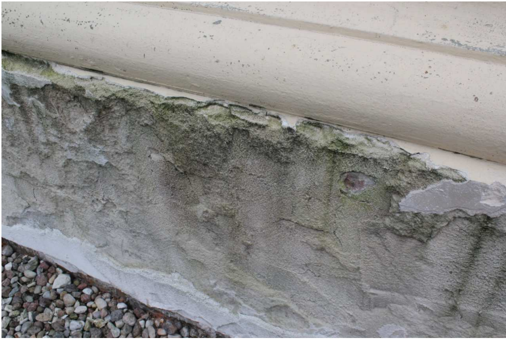
Fot. 2. Uszkodzenia wierzchniej warstwy tynków cokołowych, widoczne również czarne naloty zielenic.
